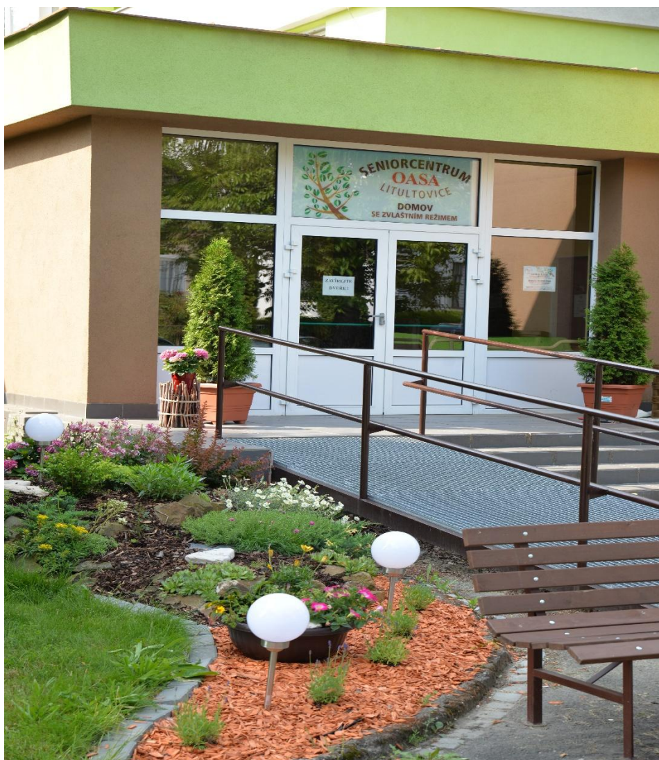
Domov se zvláštním režimem
